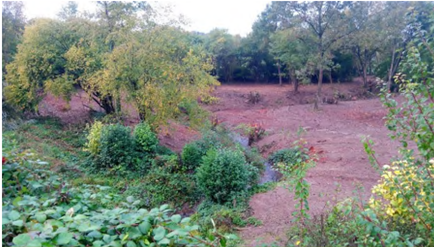
Blick in das freigestellte Regenrückhaltebecken
