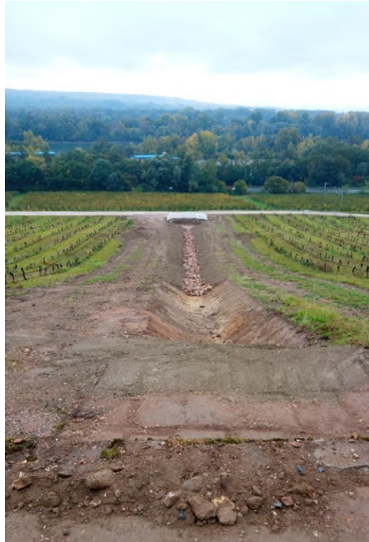
Blick auf den sich noch im Bau befindenden Entwässerungsgraben mit erhöhtem Versickerungsvermögen.
