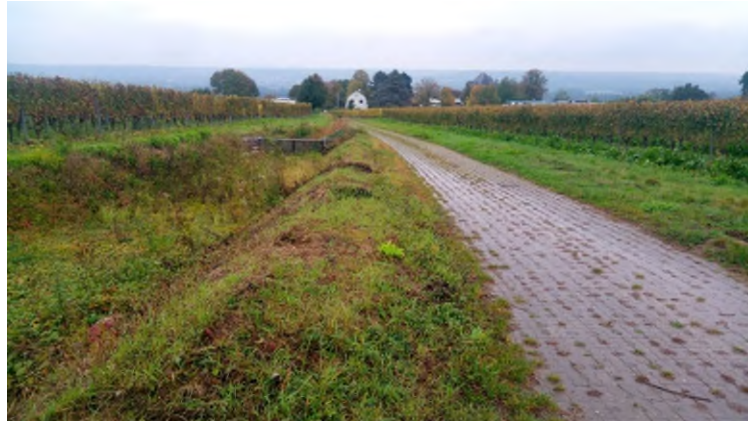
Rückhaltebecken mit Holzfang und Rasengitter-Weg
