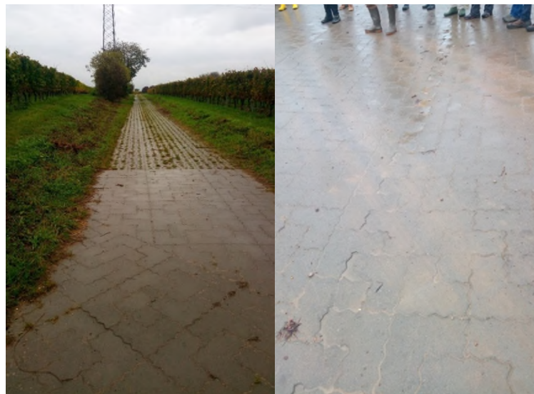
Rasengittersteine und L-förmige Pflasterung oberhalb des Rückhaltebeckens und in der flachen, gut durchfahrbaren Rinne, die als Einfluss des Rückhaltebeckens fungiert.
