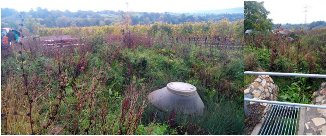
Rückhaltebecken (links) und Einlass in das Becken (rechts)
