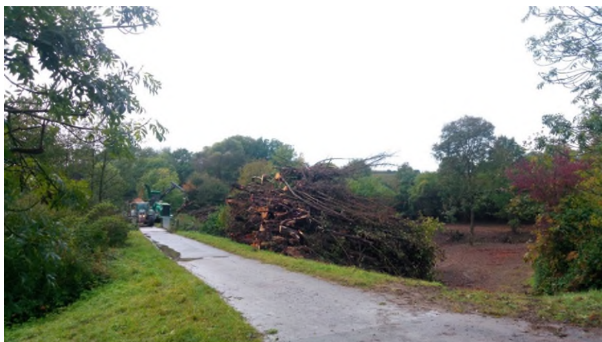
Große Mengen an Gehölzen wurden aus dem Regenrückhaltebecken geholt, das nun gehäckselt wird.
